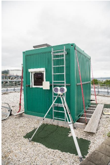
Ein grüner Container auf dem Dach der Jenaer Stadtwerke beherbergt das Teleskop zum Senden der Quantenschlüssel. Das Fraunhofer IOF liegt in 1,7 Kilometern Luftlinie Entfernung. © Fraunhofer IOF
